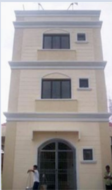
Tagaytay Radar Station
